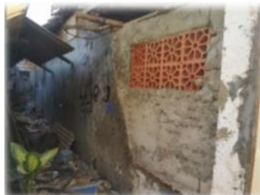
Gambar 7. Ventilasi Rumah Warga Sumber : Dokumentasi Pribadi, 2019
