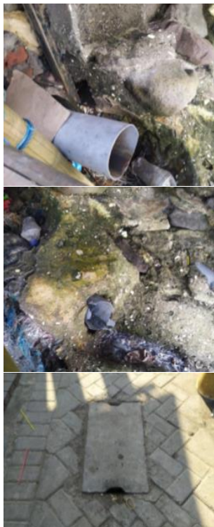
Gambar 13. Drainase Lingkungan Sumber : Dokumentasi Pribadi, 2019
