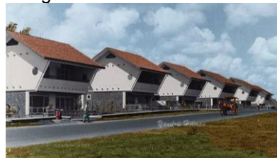
Gambar 1. Corak Awal Bangunan Arsitektur Jengki. Sumber: wikipedia
