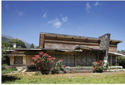
Gambar 2. Corak Baru Bangunan Arsitektur Jengki. Sumber: www.vice.com
