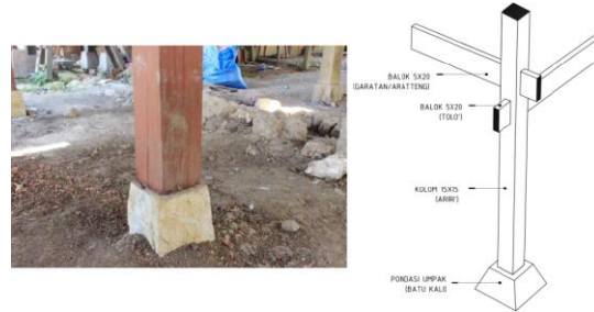
Gambar 4. Konstruksi Kolom-Pondasi Sumber: Survei Lapangan, 2018
